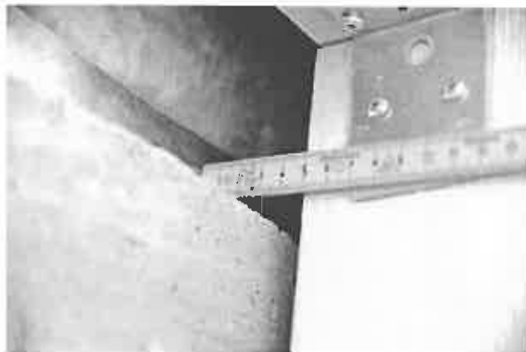
Foto 15 – 18. Eksempler på dårlig udfyldning med isolering og spalter mellem isoleringslag. Isoleringen har her – jf. foto nederst th. – været fastholdt af lange skruer på ydersiden af isoleringen.
