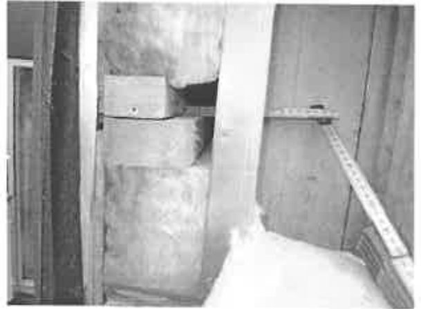
Foto 21 og 22. Abning ved hjørne hvor der kunne konstateres dybe gennemgående kanaler mellem isoleringslagene.
