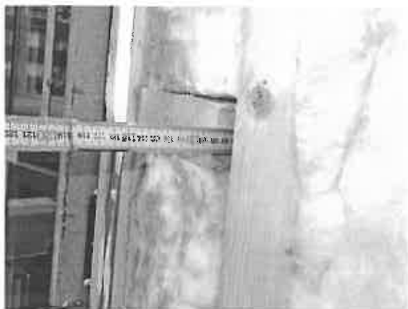
Fotos 23 – 26. Flere eksempler på spalter og kanaler mellem isoleringslag
