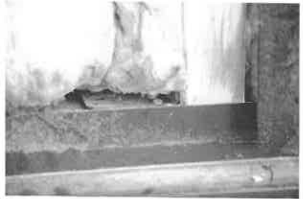
Foto 11 og 12. Eksempler på fuger mellem isolering og skelet. Bemærk mørkfarvningen af isoleringen som indikerer at der har været indtrængning af luft.
