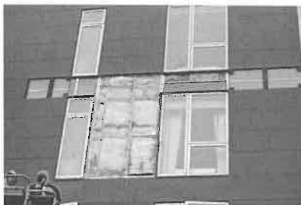
Fotos 29 og 30. Abning af facade. Der ses mørkfarvning af isolering som en indikation af, at der er trukket kold luft ind bag vindafdækningen.
