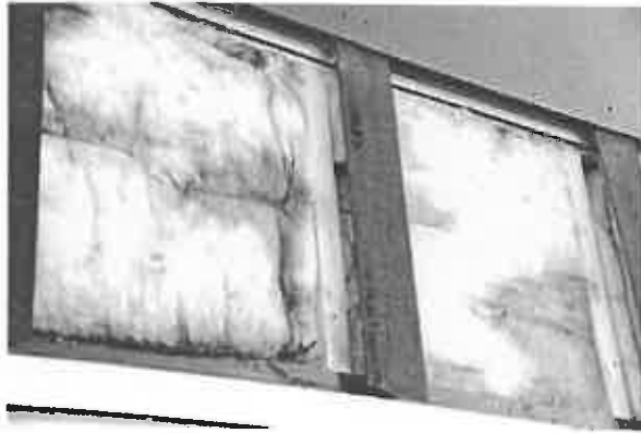
Foto 11 og 12. Eksempler på fuger mellem isolering og skelet. Bemærk mørkfarvningen af isoleringen som indikerer at der har været indtrængning af luft.
