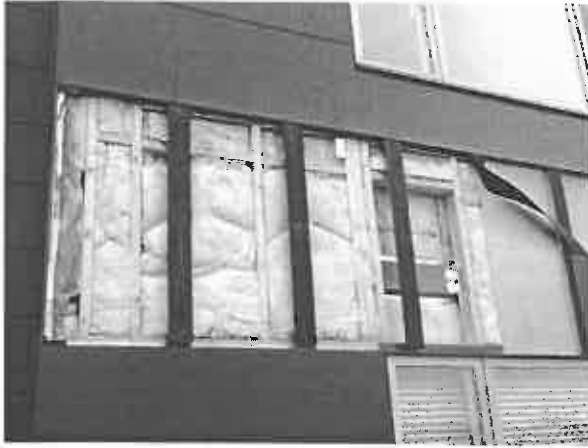
Foto 21 og 22. Abning ved hjørne hvor der kunne konstateres dybe gennemgående kanaler mellem isoleringslagene.
