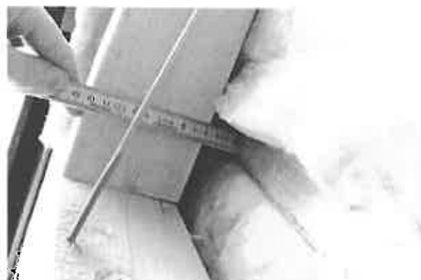
Foto 15 – 18. Eksempler på dårlig udfyldning med isolering og spalter mellem isoleringslag. Isoleringen har her – jf. foto nederst th. – været fastholdt af lange skruer på ydersiden af isoleringen.
