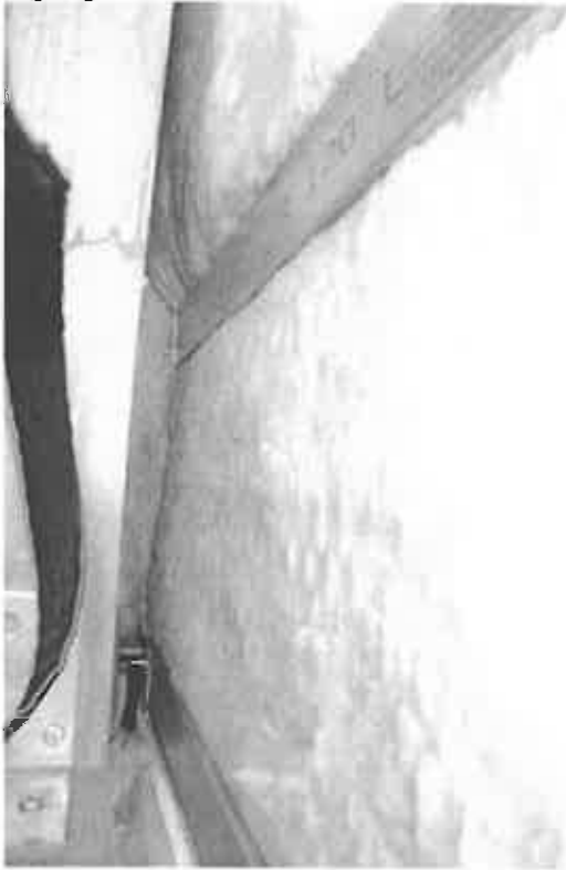
Foto 21 og 22. Abning ved hjørne hvor der kunne konstateres dybe gennemgående kanaler mellem isoleringslagene.
