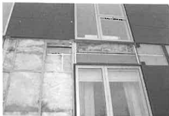
Fotos 29 og 30. Abning af facade. Der ses mørkfarvning af isolering som en indikation af, at der er trukket kold luft ind bag vindafdækningen.
