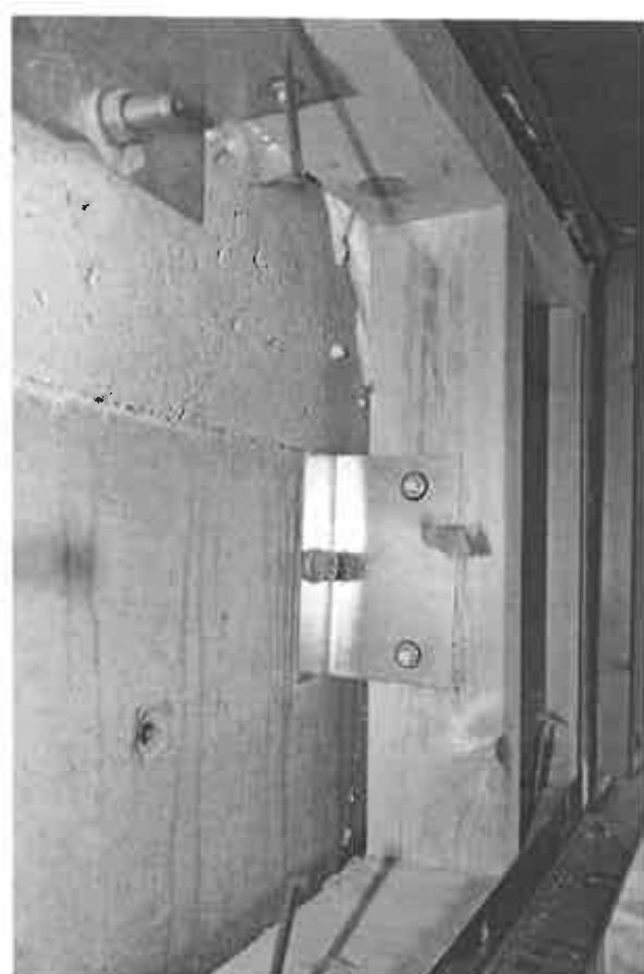
Foto 15 – 18. Eksempler på dårlig udfyldning med isolering og spalter mellem isoleringslag. Isoleringen har her – jf. foto nederst th. – været fastholdt af lange skruer på ydersiden af isoleringen.
