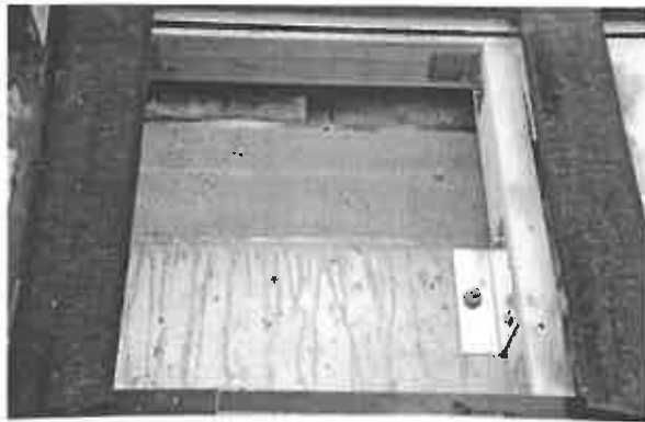
Foto 13. Træskelet er anbragt uden på betondæk mv., og der er en spalte mellem træskelet og underlag.
