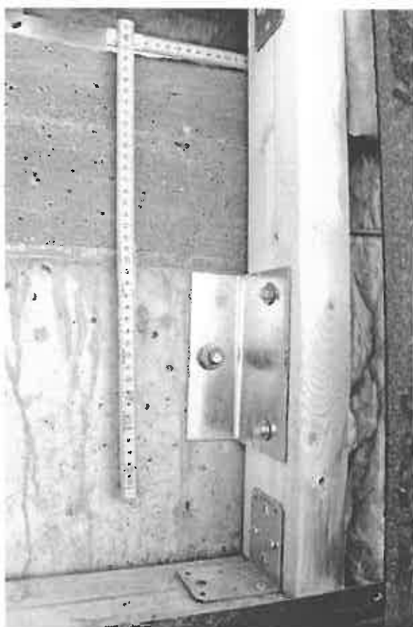
Foto 19 og 20. Spalte mellem beton og træskelet.
