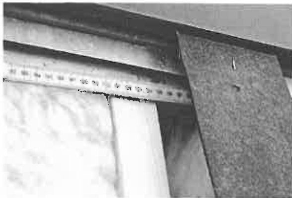
Foto 13. Træskelet er anbragt uden på betondæk mv., og der er en spalte mellem træskelet og underlag.
