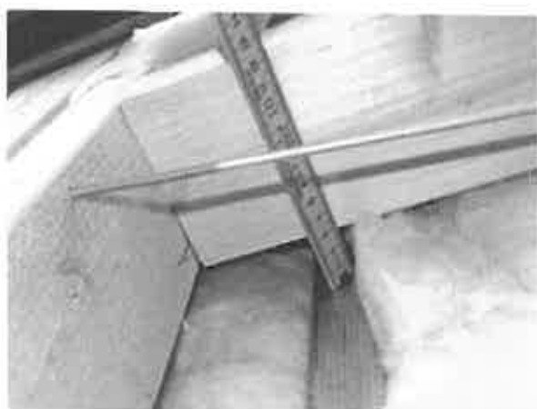
Fotos 27 og 28. Fastholdelse af isolering med lange søm eller skruer på ydersiden af isoleringen.
